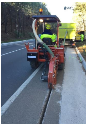
Exemple de treballs d'obertura de la microrasa
