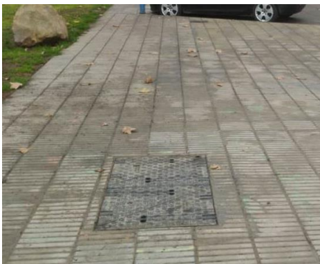
Exemple pericó tipus C2 en Vorera
