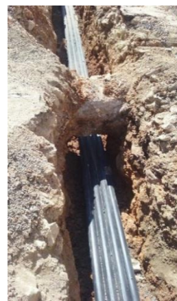
Exemple execució de cala amb detecció de serveis i minatge de canonada d'aigua.
