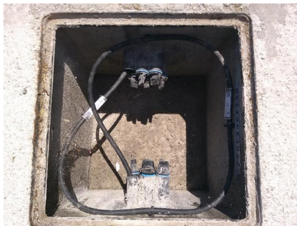
Exemple de pas de cable per pericó
