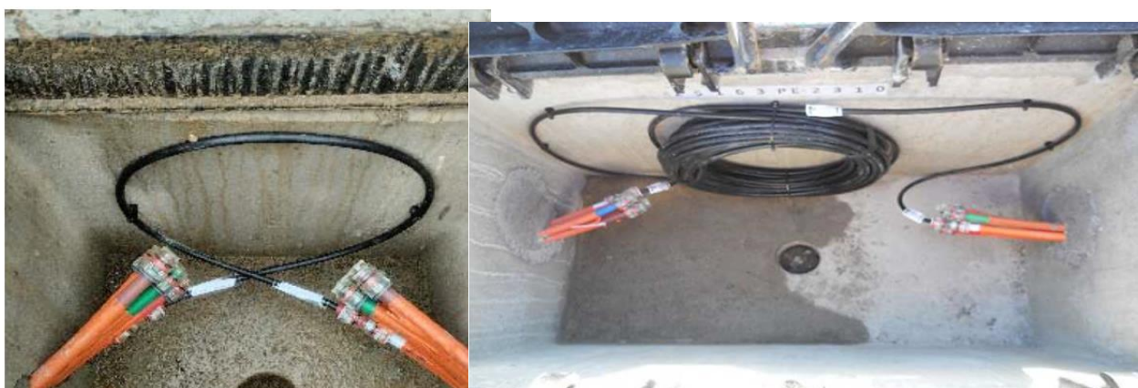
Exemples Terminació microductes en pericó
