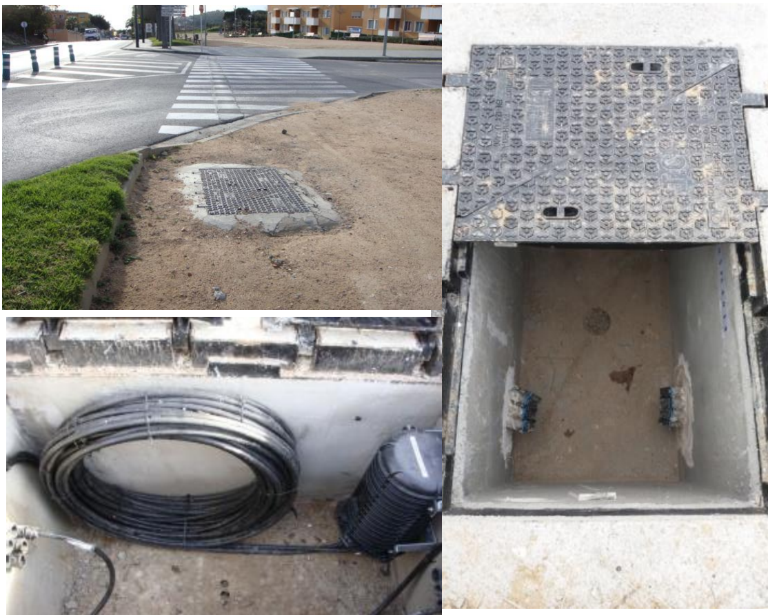
Detall interior pericons tipus C
